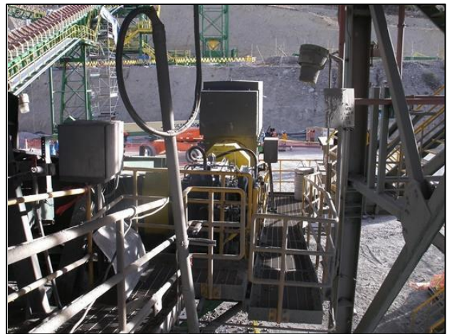
COMPA A MINERA ANTAMINA S.A. – Faja Transportadora.
